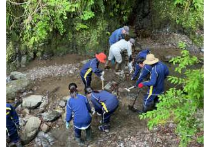
沢の水が取水口に向かうように堤防を作り、流れを変えます。
