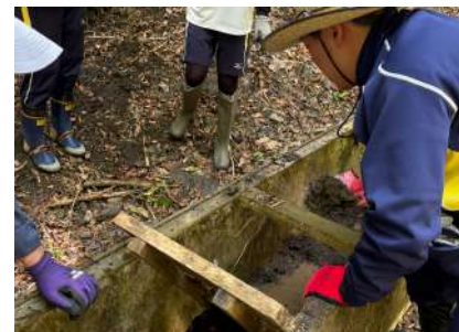
取水口近く泥や落ち葉を溜めるプールの泥を除去しています。
